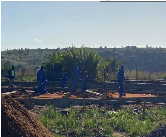
Fig. 10: Grado de construcción de la "casa madre" a mayo de 2022
