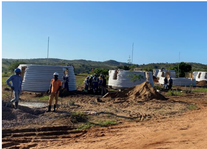
Fig. 9: Grado de construcción de los "domos" a mayo de 2022
