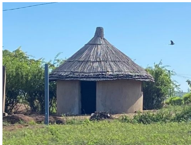
Fig. 4: Construcción tradicional circular en Xai-Xai
